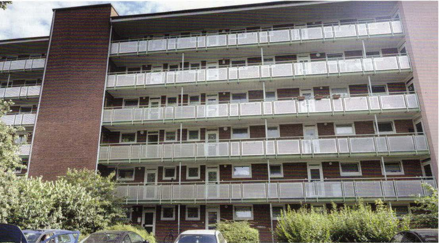
Von Kakerlaken befallenes Wohnhaus in Horn
