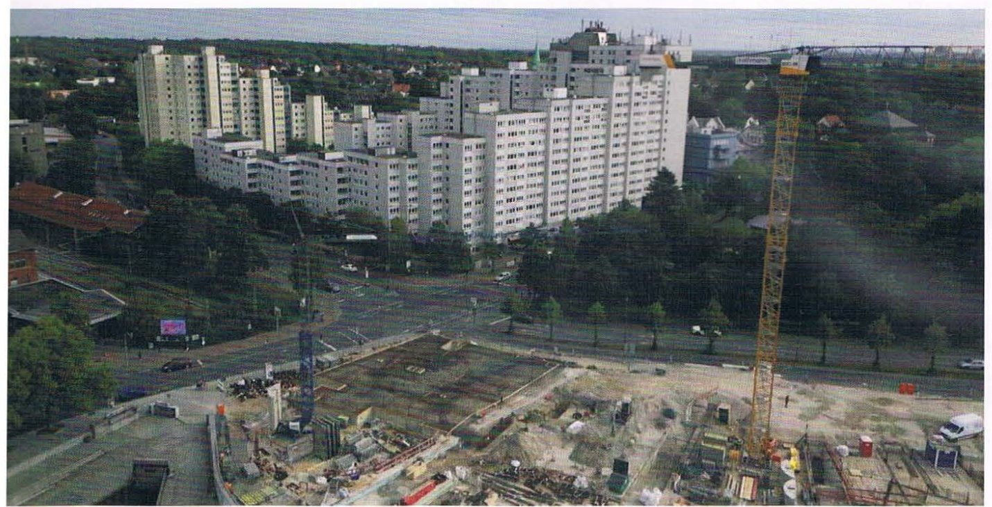
Grohner Düne und Bullen-Baustelle
